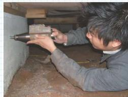
シミュットハンマー試験でコンクリート強度のチェックもしっかり行い、耐震補強
