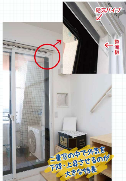
▲DIウインドウ(平面図③) 既存の窓の内側に、換気プレス(ガラの)の付いたDIウインドウを設置。Mさま邸の場合、壁にある外気導入用のダクトからDIウインドウに外気を入れて、窓と窓の間で熱交換(外へ逃げようとする熱を回収)を行っています
